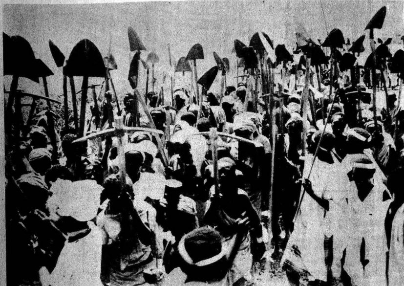
Los constructores de un nuevo imperio: Italia proporciona palas y picos a los abisinios de las zonas capturadas para que trabajen en la construcción de nuevas carreteras. Mussolini paga a sus obreros mejor que el negús.
